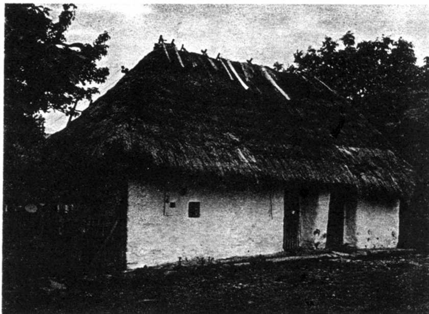
Obytná časť laznickej usadlosti Fišerovcov V lazích . Hrušov. Foto T. Szabó 1980
