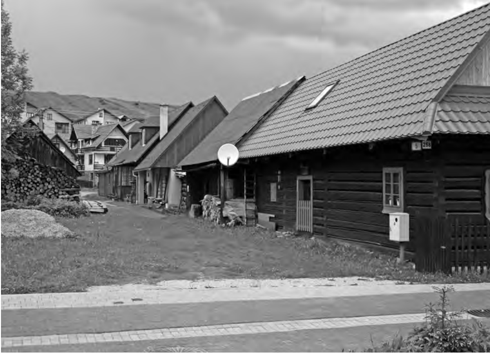
Upravená tradičná architektúra, v pozadí výstavba zo sedemdesiatych rokov. (Z. Beňušková 2012)
