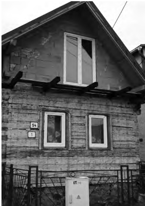
Prestavba drevenice s použitím rôznych materiálov. (Z. Beňušková 2013)
